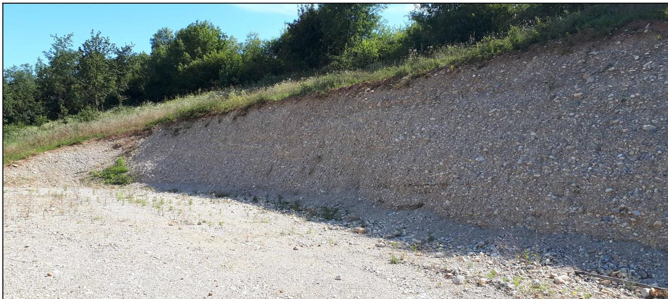
**Figure 2 : Affleurement de graves sableuses compactes au niveau d'un terrassement**
