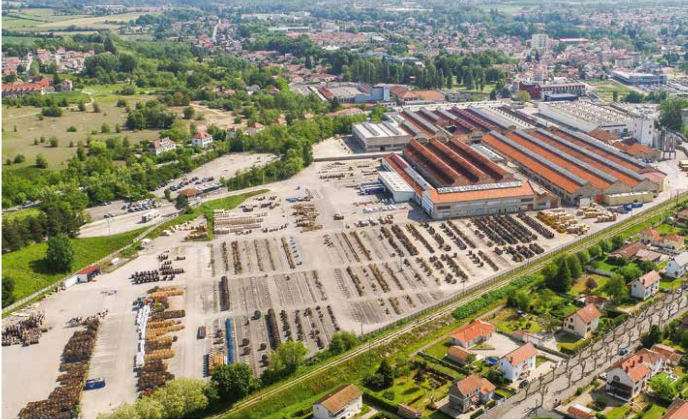
▪ Les usines Grammont entre Pont de Chérury et Charvieu-Chavagneux, aujourd'hui exploitées par Prysmian ▪
