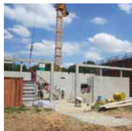
Construction de l'école maternelle Petit Prince 4 271 300 €
