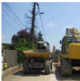
Travaux de voiries 1 045 200 €
