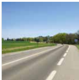
Réalisation d'un passage souterrain sous la RD 517 474 800 €
