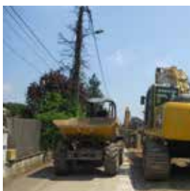
Travaux de voiries 1 941 300 €
